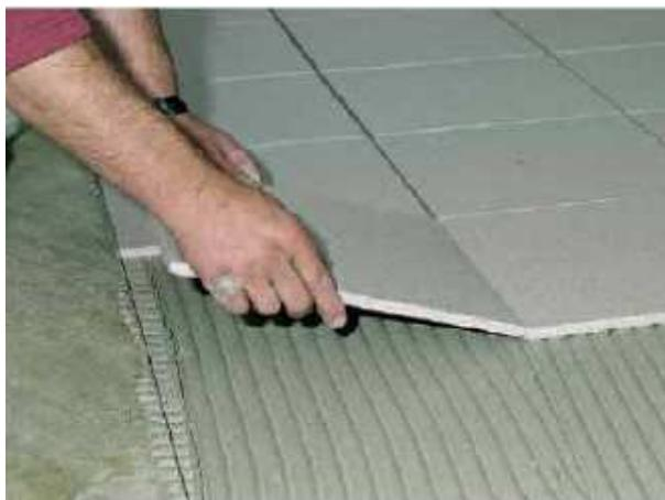
PCI<sup>®</sup> Nanoflott применяется, как для укладки полужидким, так и тонким слоем
